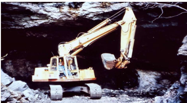
Arild Omestad med gravemaskin på Knipane
