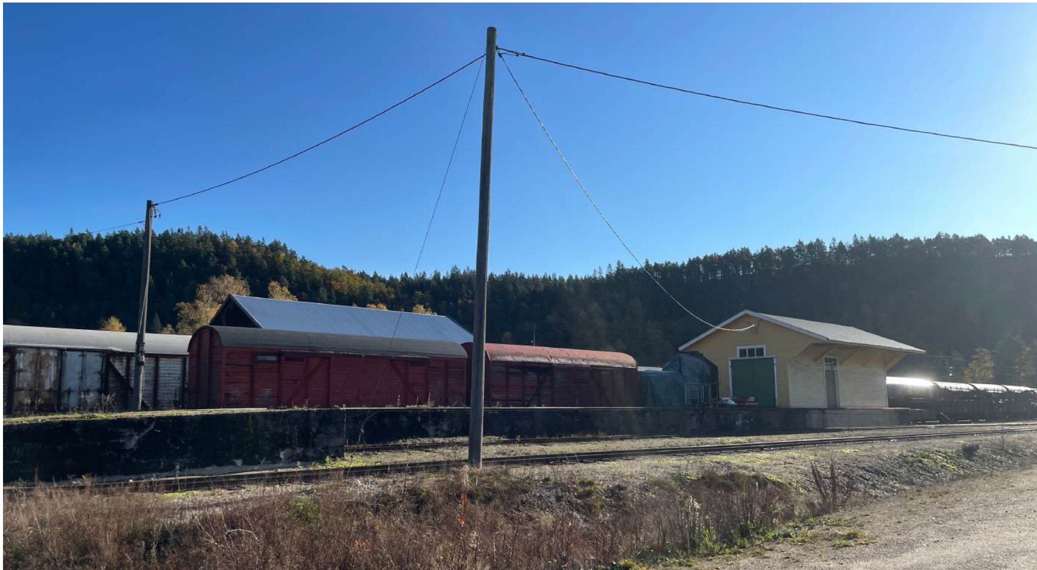
Inspirasjonsbygg på Verkstedsområdet ved Steinsfosssvegen
