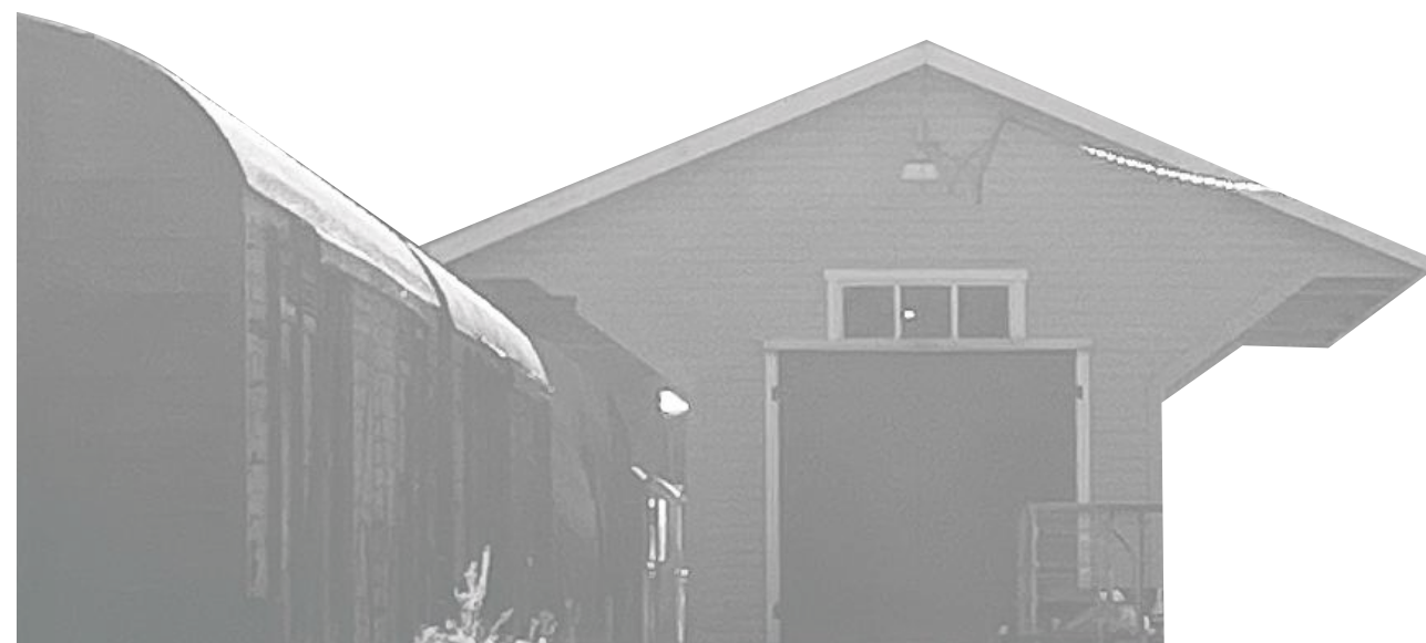
Inspirasjonsbygg på Verkstedsområdet ved Steinsfosssvegen
