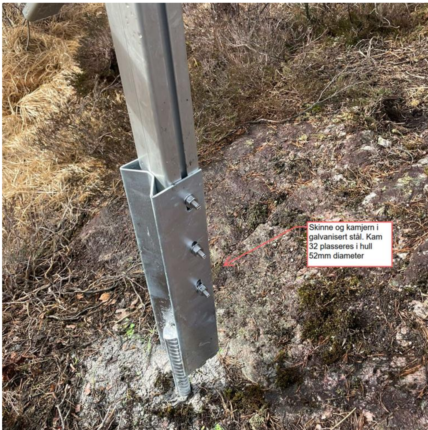
Fundamentering av solcellestativ. Figur 8 i planinitiativet
