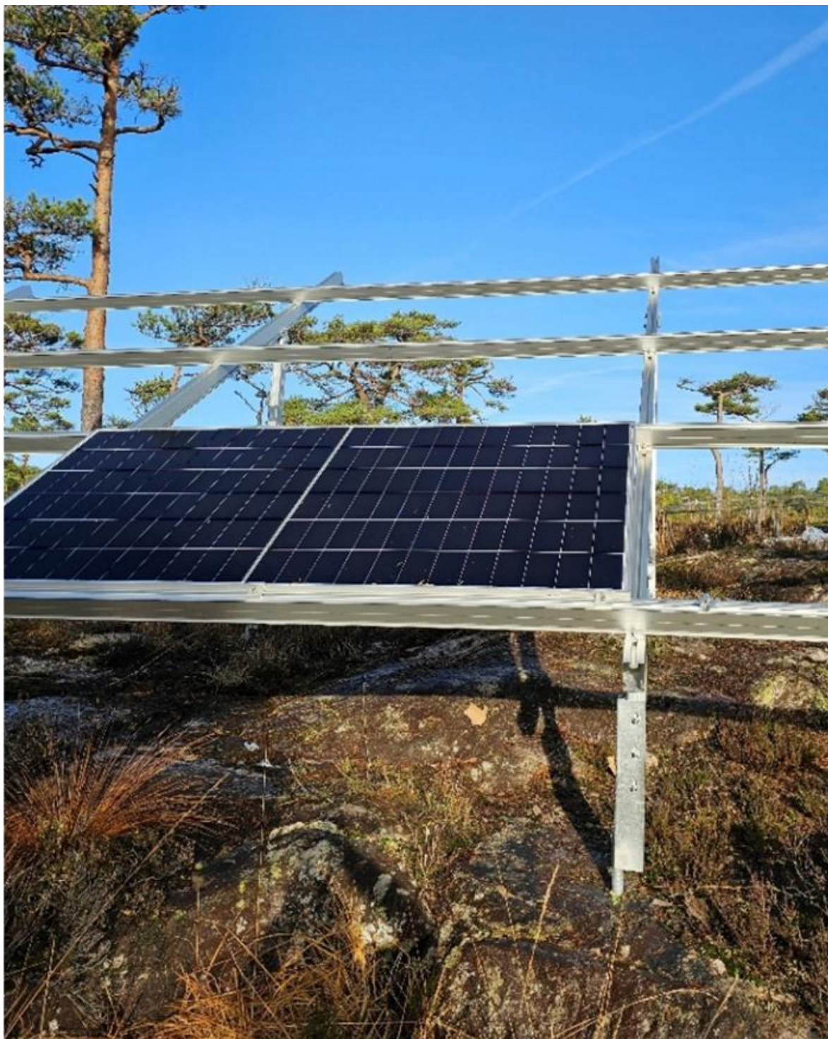
Figur 9 Eksempel på solcellestativ med panel.
