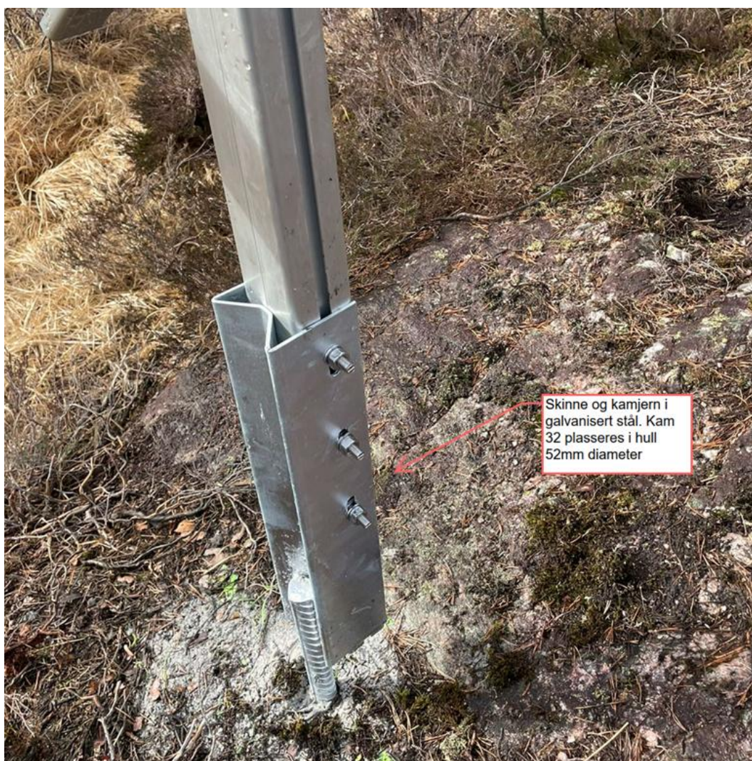
Figur 8 Fundamentering av solcellestativ.
