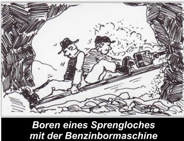
**Boren eines Sprengloches mit der Benzinbormaschine**
